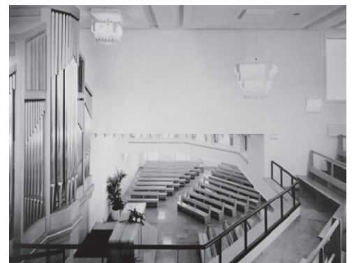
9 Neupostolische Kirche, Teff Sarasin, Blick in den Kirchenraum vor dem Umbau.
